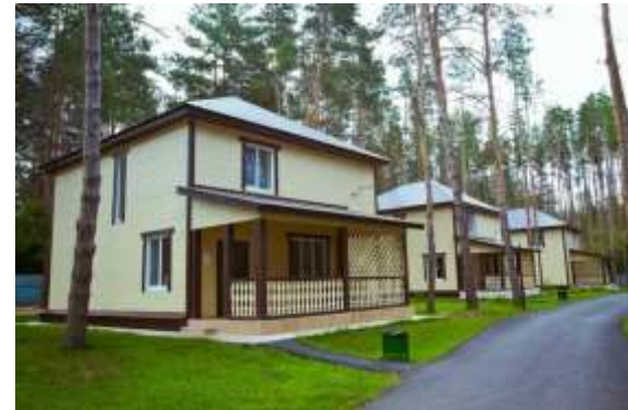
Строительство базы отдыха в д. Гуляево
