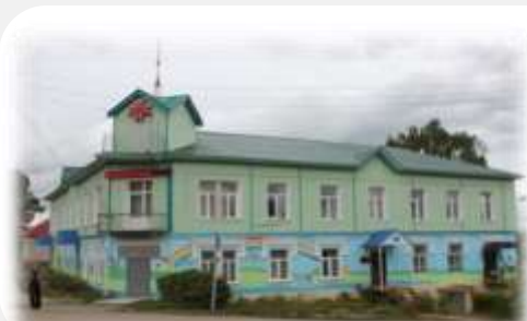
Здание волостного правления, с. Вавож
